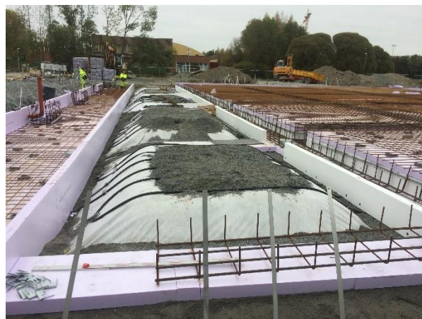
Attēls 6. Grunts apsildes caurules ir pirmā grīdas kārtā.
