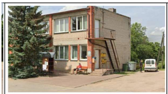
1.-3.attēls. Ēkas fasādes.
